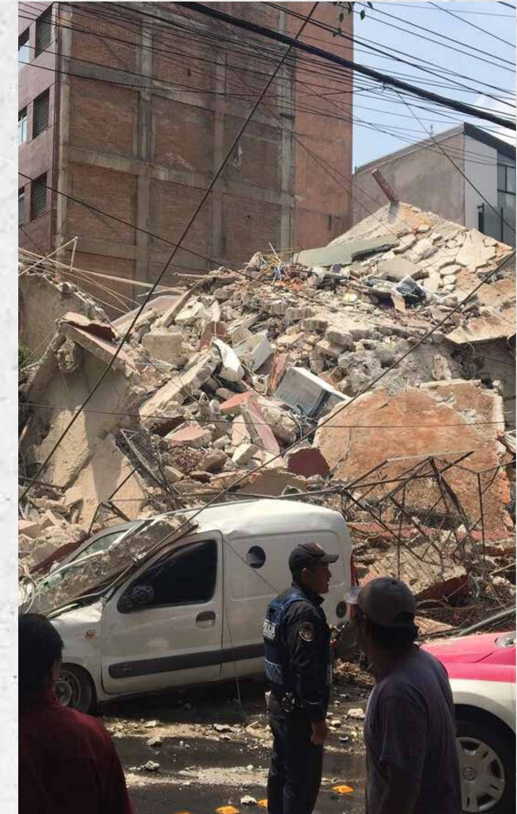
Fig. 12 Edificio colapsado por el sismo con magnitud de 7.1, (2017). Recuperado de: https://expansion.mx/nacional/2017/09/19/sismo-en-mexico-deja-decenas-de-muertos#uuid00000164-01aa-db07-a166-3fab29f7002d
