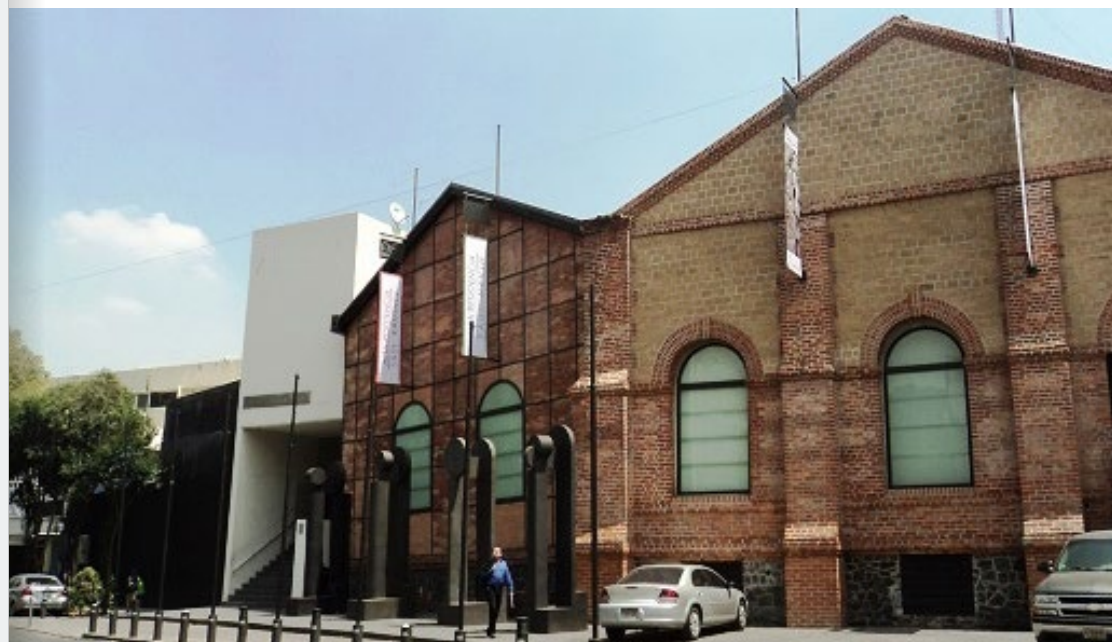
Imagen 110. Fachada de Estación indianilla
