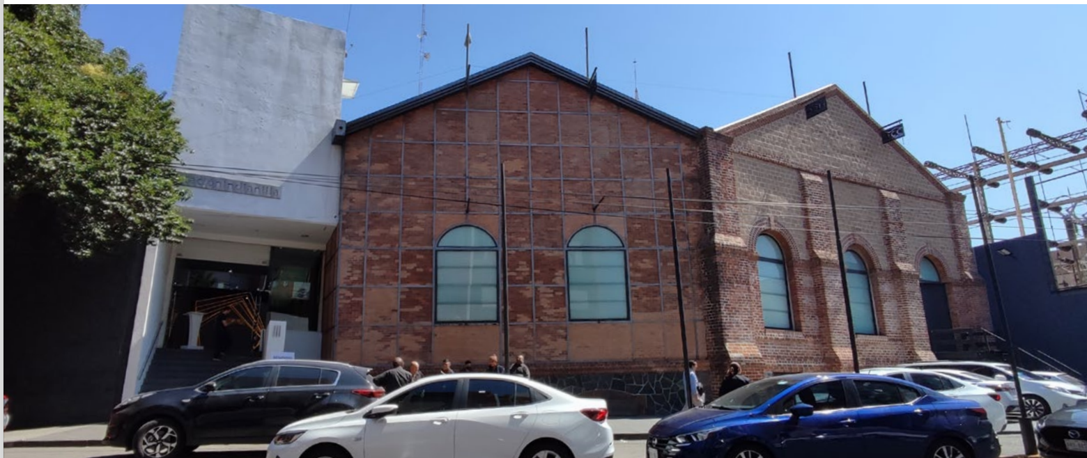
Imagen 18. Fachada de Estación Indianilla.
