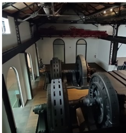
Imagen 120. Vista desde el primer piso
