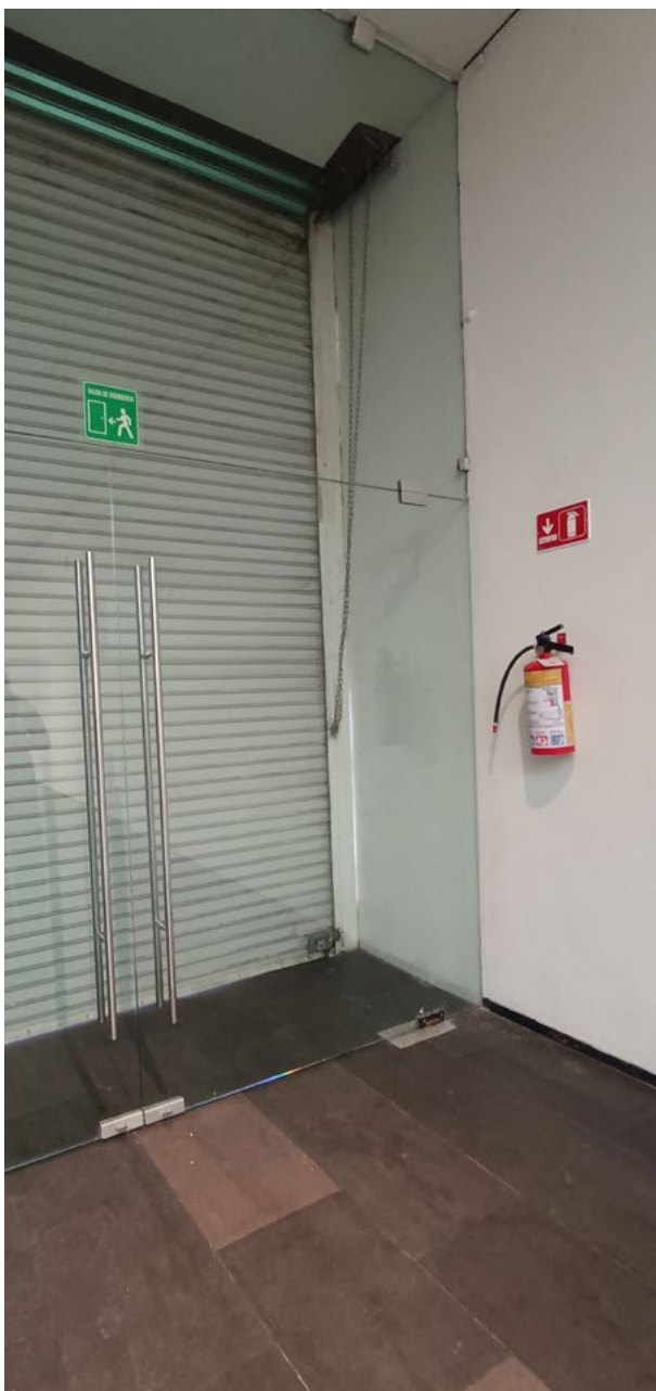
Imagen 140. Entrada del venue, extintor y señalamiento de ruta de evacuación
