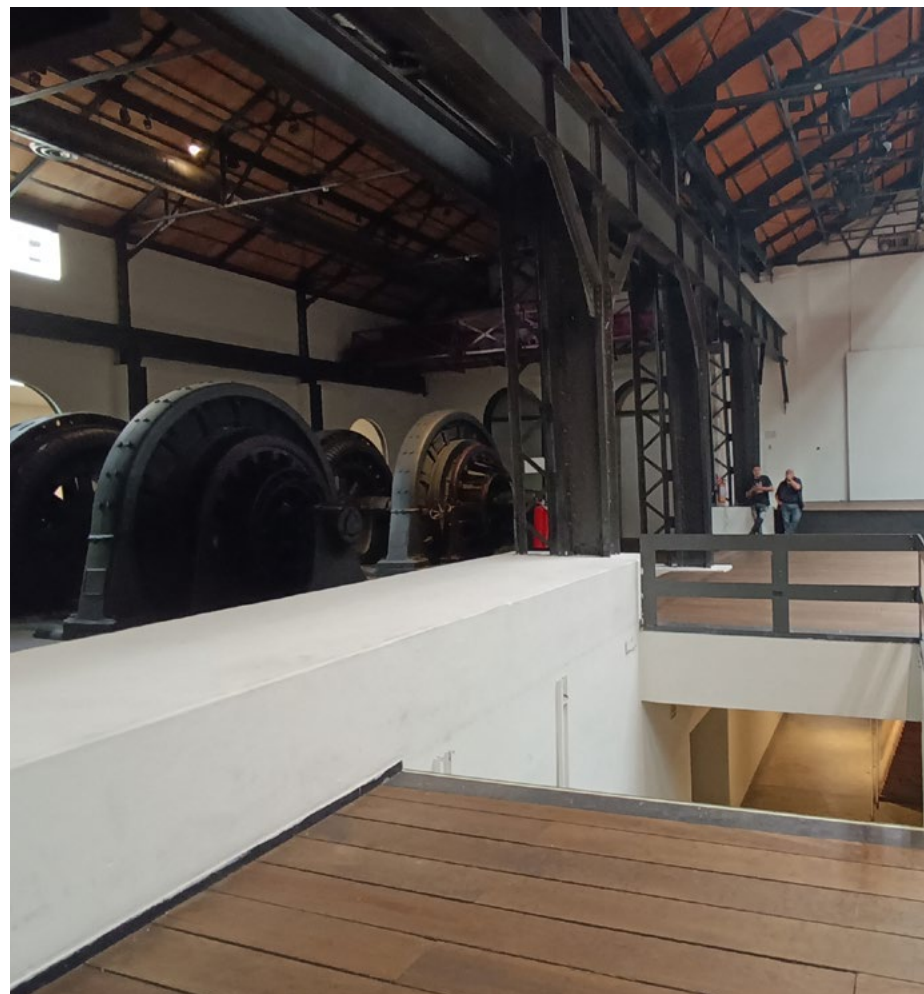
Imagen 119. Turbinas y zona de escaleras
